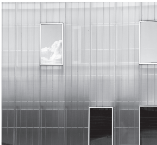
Értelmező szándékkal készített fotográfia, amely láttatni képes, hogy a polikarbonát főhomlokzat ívébe illesztett üvegfelület visszatükrözi Deptford barokk templomának tornyát és az eget (Fotók: Czákó Zsolt 2011)
